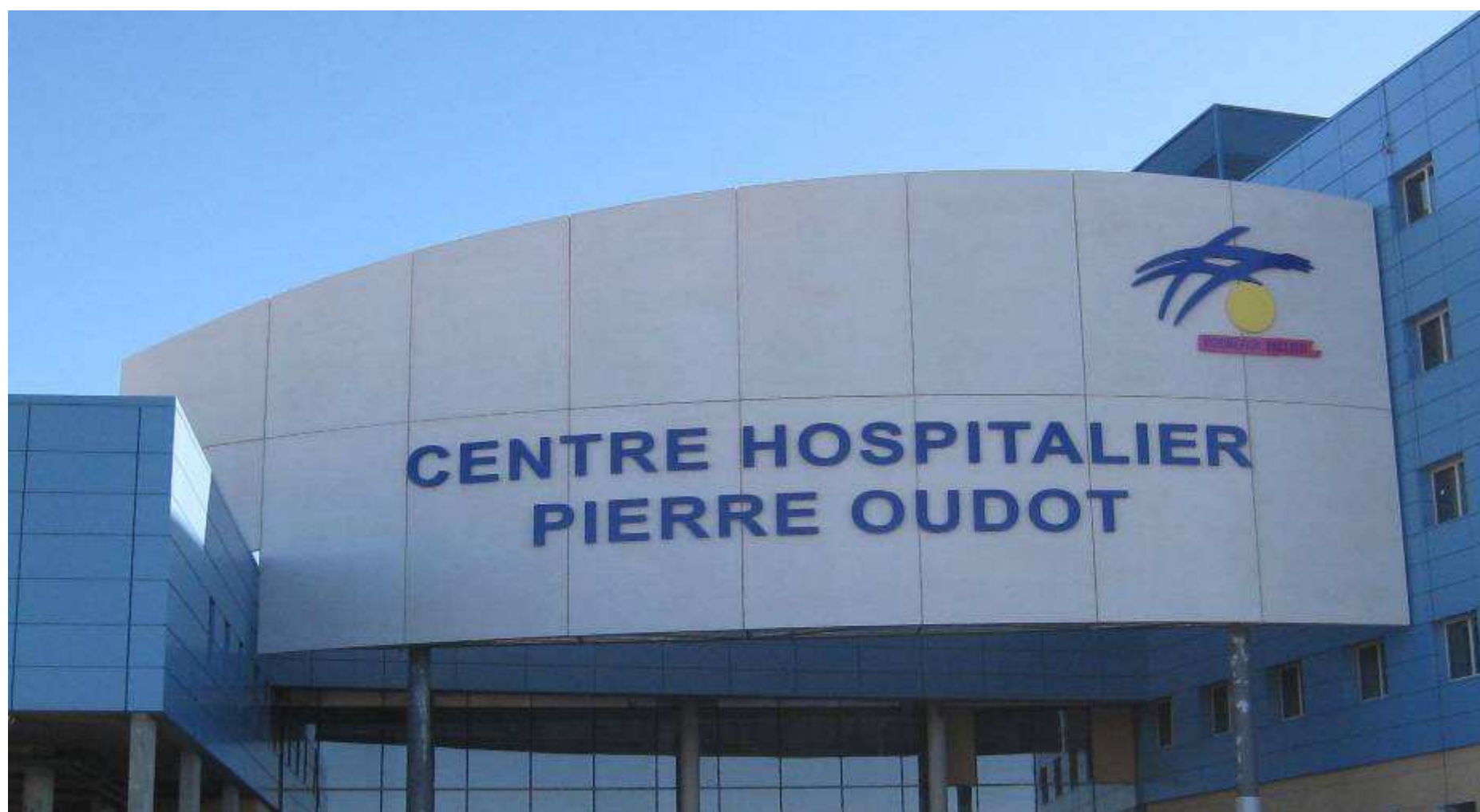
POSE DE LA SIGNALÉTIQUE DU MUR SIGNAL
