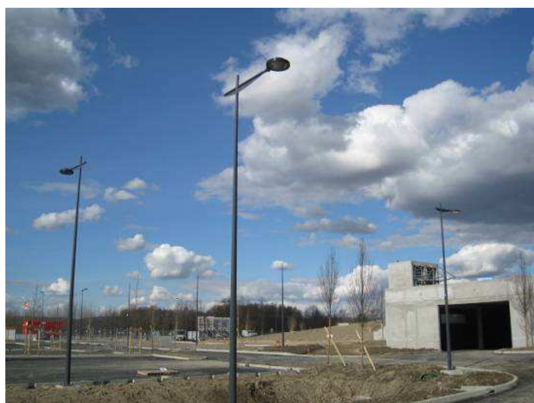
POSE DES CANDELABRES ET DE LA CLOTURE PERIPHERIQUE
